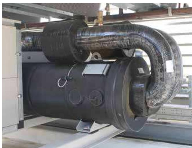
Photo à gauche : L'installation, composée d'un ballon tampon et d'une installation de pompe redondante, est pilotée par un mélange d'eau glycolée Proviflow.
