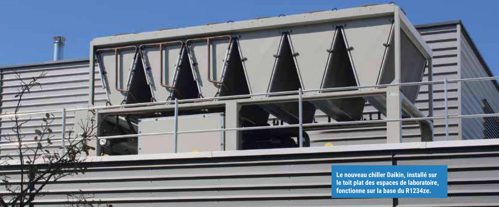
Le nouveau chiller Daikin, installé sur le toit plat des espaces de laboratoire, fonctionne sur la base du R1234ze.
